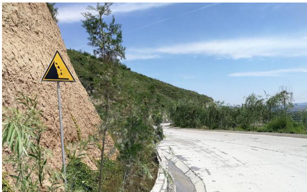
照片 2-18 矿山道路排水渠
