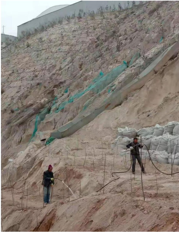
照片 2-8 矿区废渣边坡治理 1
