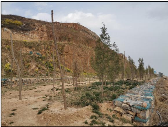
照片 2.6-3 采场平台设置挡墙、覆土绿化
