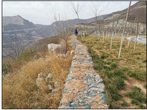
照片 2.6-2 矿山道路设置挡墙、覆土绿化
