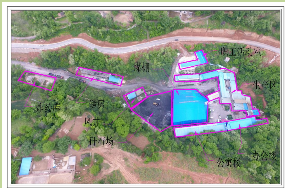
照片 3-11：矿山联合工业场地主要建筑损毁土地现状
