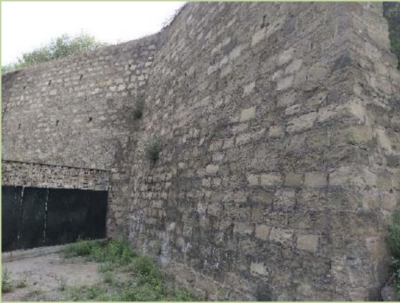
照片 2-12 场地边坡修建挡墙（镜向 S）
