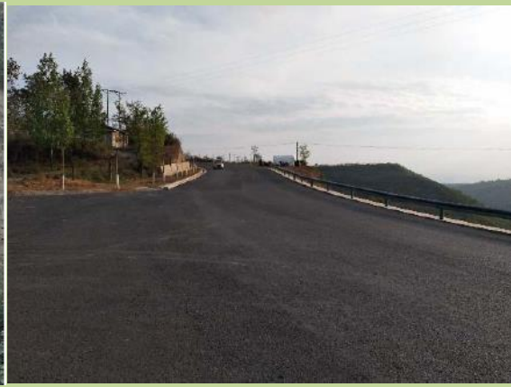
照片 2-13 维修公路（镜向 N）
