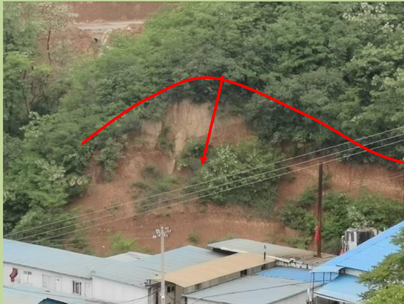
照片 3-1 By1 崩塌隐患（镜向 260°）
