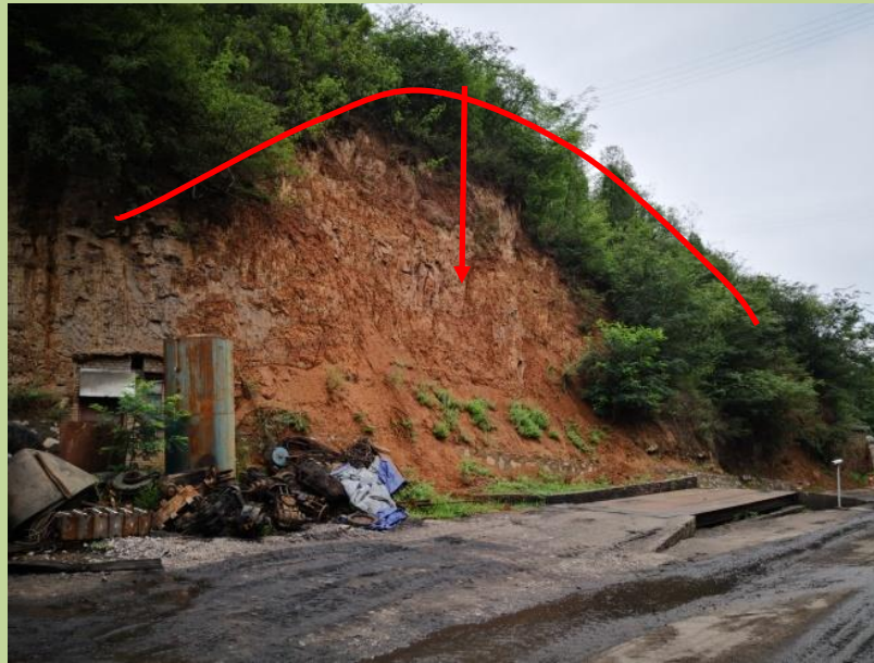
照片 3-3 By3 崩塌隐患（镜向 45°）
