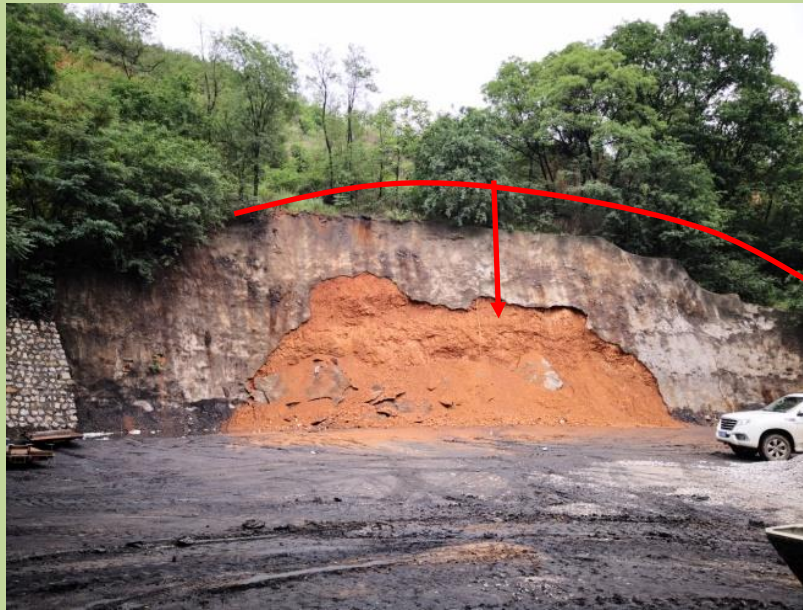
照片 3-2 By2 崩塌隐患（镜向 260°）
