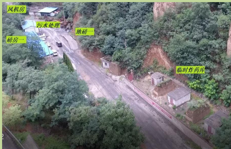
照片 1-2 联合工业场地建筑二（镜向 315°）
