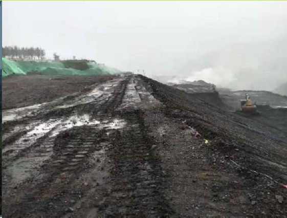
照片 2-17 排矸场治理（SW）
